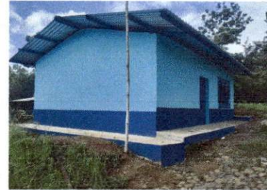
Foto 2: TRABAJO TERMINADO EN EL LEVANTAMIENTO DE LA PARED
